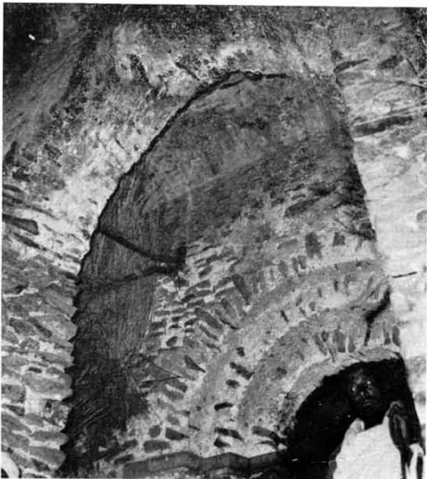
Fig. C. — Église de Barié-Guemb. Le système de double-voute, face à l'entrée principale du maqdas, en ouest.
