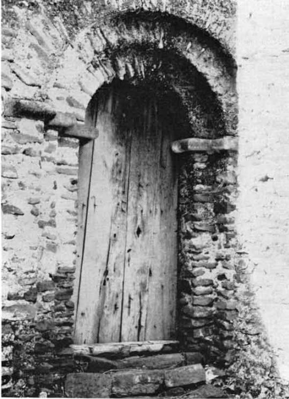
Fig. 7. — Barié-Guemb. La porte nord du maqdas. Remarquer la triple voussure et le coussinet mouluré de grès rouge (qui n'existe pas sur les portes des façades extérieures). À droite, un pilier fait face à la porte.
